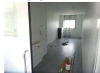
工事中のトイレ
