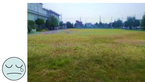
整備作業前の様子
