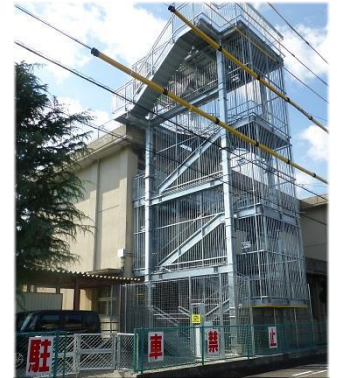
完成した避難階段
