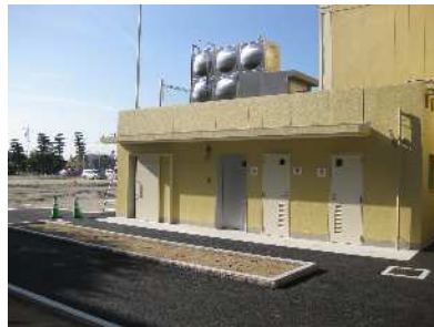
職員室横には屋外トイレと体育倉庫が
