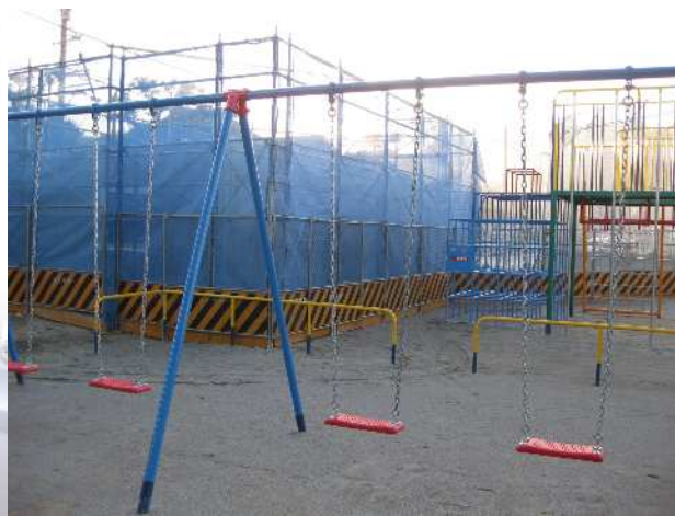
つち もすっかり入れ替えたグラウンドに倉庫を建設中。
