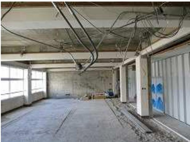
写真は、旧図書室（職員室の真上）のようすです。配線とコンクリートがむき出しで、これから床を貼ったり、天井をつけたりします。来年度以降の児童数増加に対応するため、新しい教室2つ分に生まれ変わります。10月に完成予定です。
